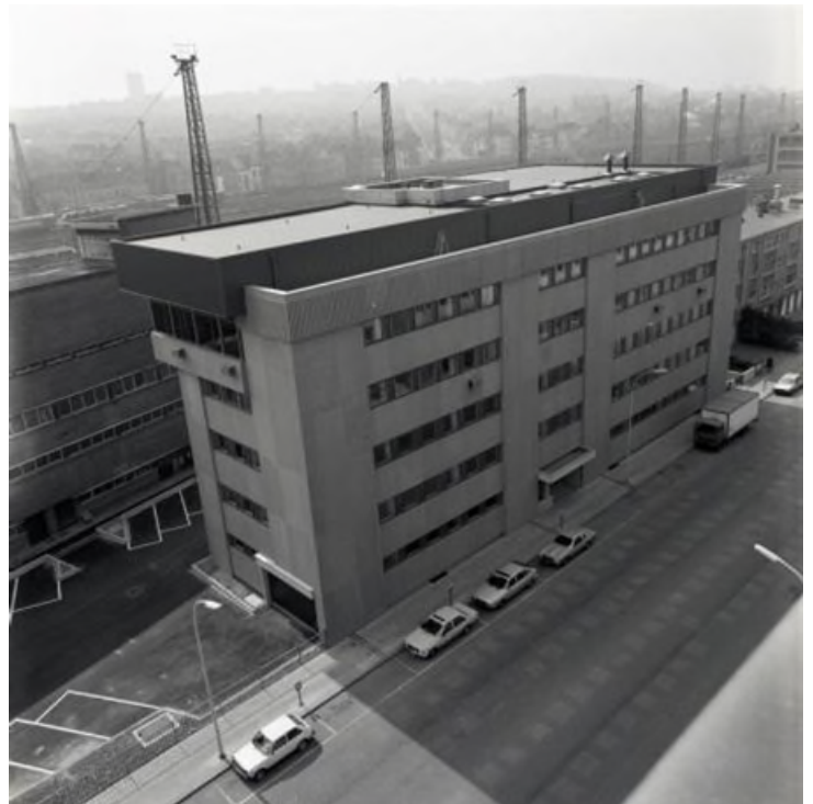
Vue extérieure de la cabine de signalisation 2 à Bruxelles-Midi (Réf. Z03862)
