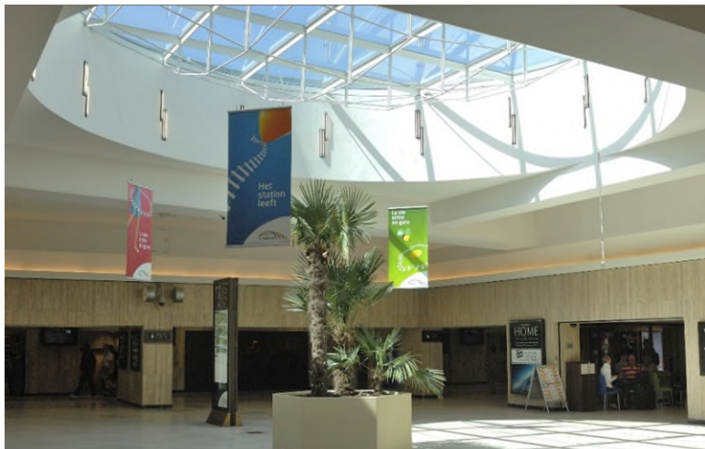
Coupole du nouveau couloir central (Réf. D3326-01)
