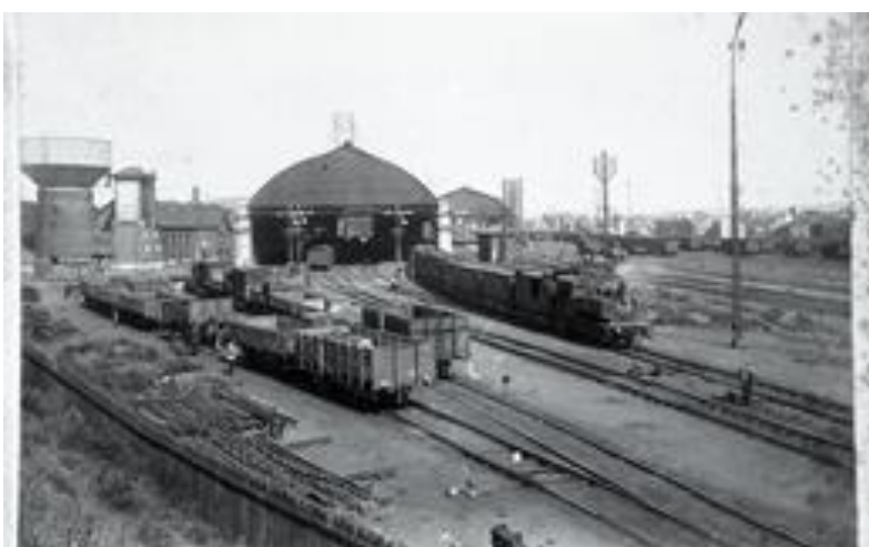
La cour à marchandises de la gare de Charleroi-Sud, côté Bruxelles, avec une vue des deux marquises (Réf. D0966-25)
