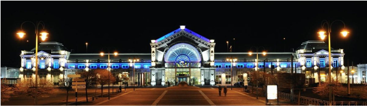
Façade de la gare éclairée après sa rénovation, 27 mars 2010 (Réf. D3442-03)
