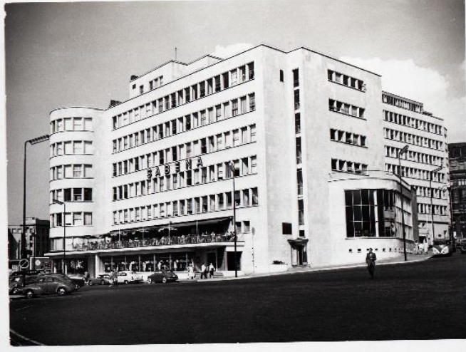
Bâtiment de la Sabena à la Gare Centrale (Réf : Z07238E)
