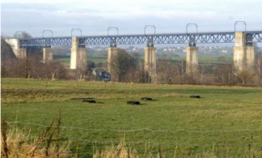
Viaduc de Moresnet après électrification (Réf. D3249)
