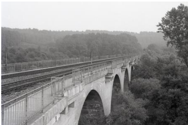
Viaduc de Remersdael (Réf. MZ20011)
