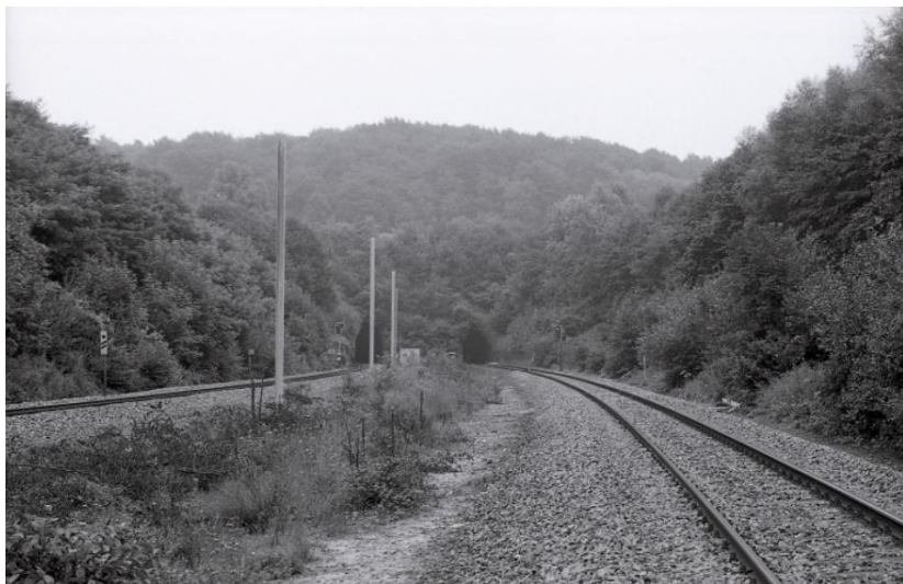
Tunnel de Veurs (Réf : MZ19971)
