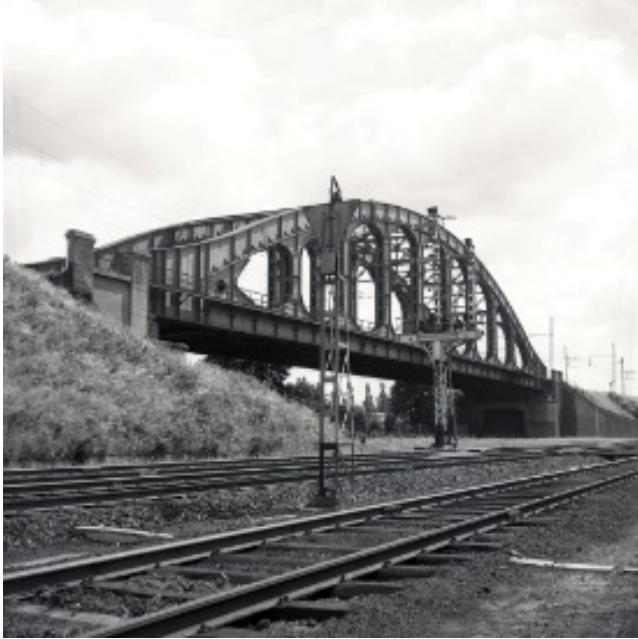
Pont ferroviaire à Malines (Réf. Z07990)
