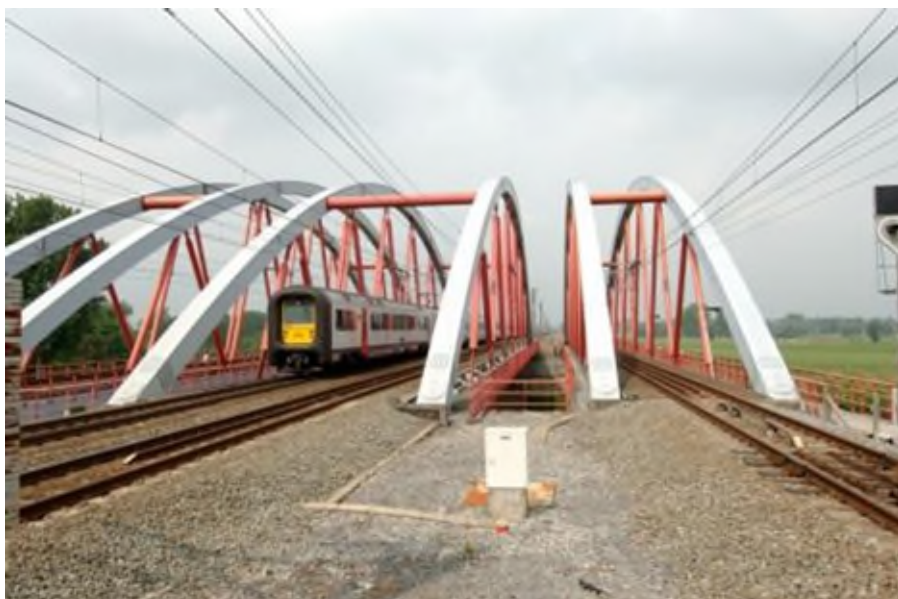
Travaux de dédoublement des voies entre Gand et Bruges 2007 (Réf. L3081-02)
