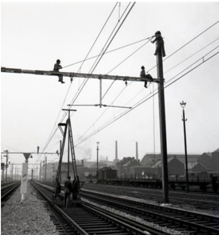
Elektrificatiewerken op lijn 124 (Brussel – Charleroi) in 1949 (Ref. Z09643f)
