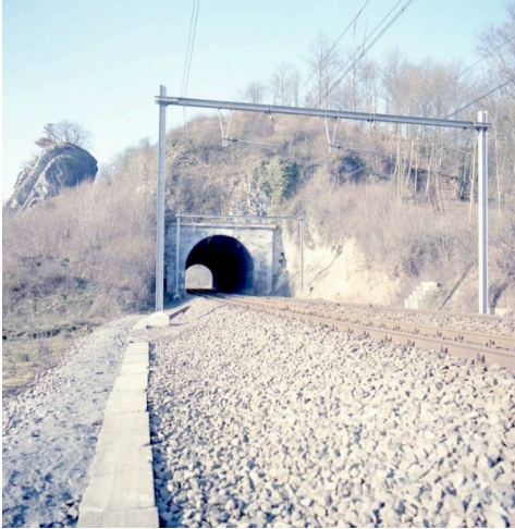
Tunnel van Godinne, februari 1989 (Ref. K00867)
