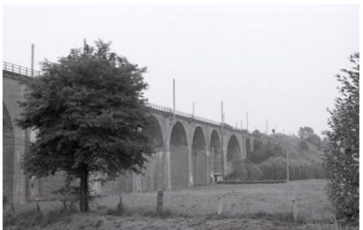
Viaduct van Sint-Martens-Voeren (Ref. MZ19929)
