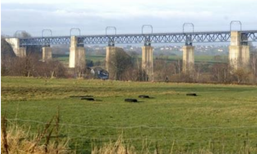
Viaduct van Moresnet na elektrificatie (Réf. D3249)
