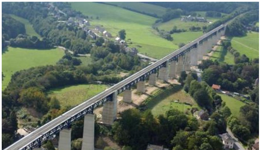
Luchtfoto's van het viaduct van Moresnet (Ref. L2651)
