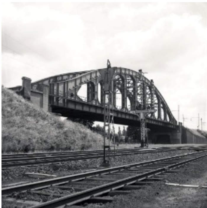
Spoorwegbrug in Mechelen (Ref. Z07990)
