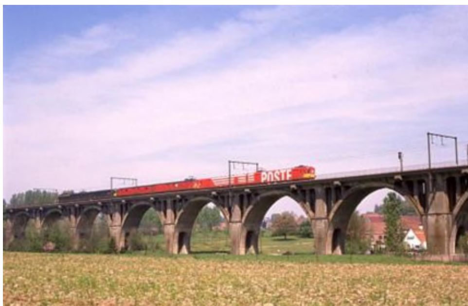
Elektrisch postmotorstel op het viaduct van Sint-Anna-Pede (Ref. M038-005)
