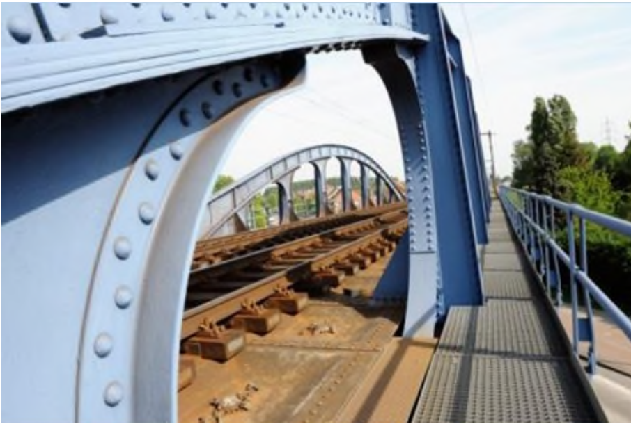
Vierendeelbrug op lijn 50A te Brugge (Ref. L3704-34)
