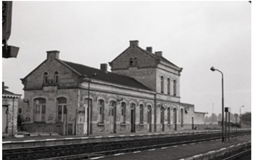
Het station Bierk (Ref. MZ06052)
