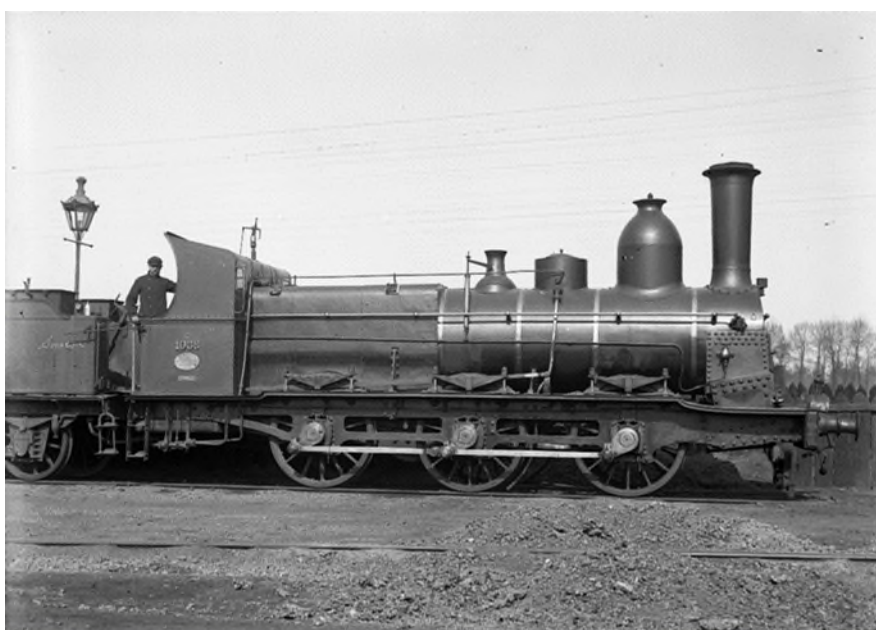
Locomotive à vapeur 1038 des Chemins de fer de l'Etat belge équipée d'un abri de type "baquet" (Réf. Q1173)
