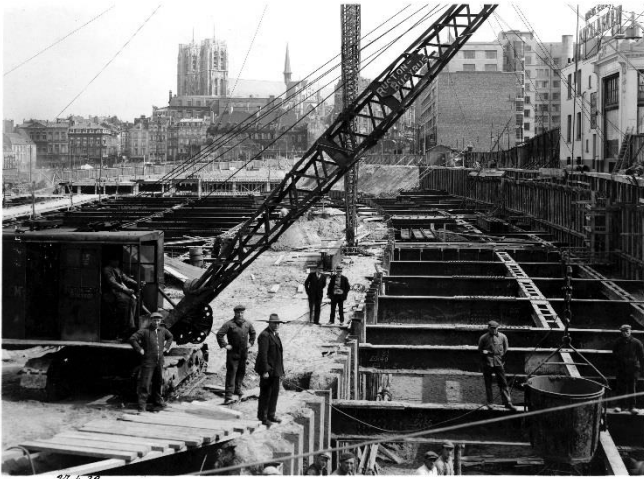
Werk van de Noord-Zuidverbinding: tunnel ter hoogte van station Brussel-Centraal, Sergysels & Dietens, 1939 (Ref. Z07013)
