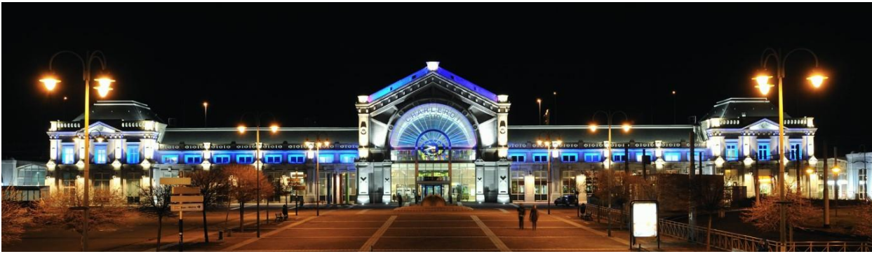
Verlichte voorgevel van het station na renovatie, 27 maart 2010 (Ref. D3442-03)
