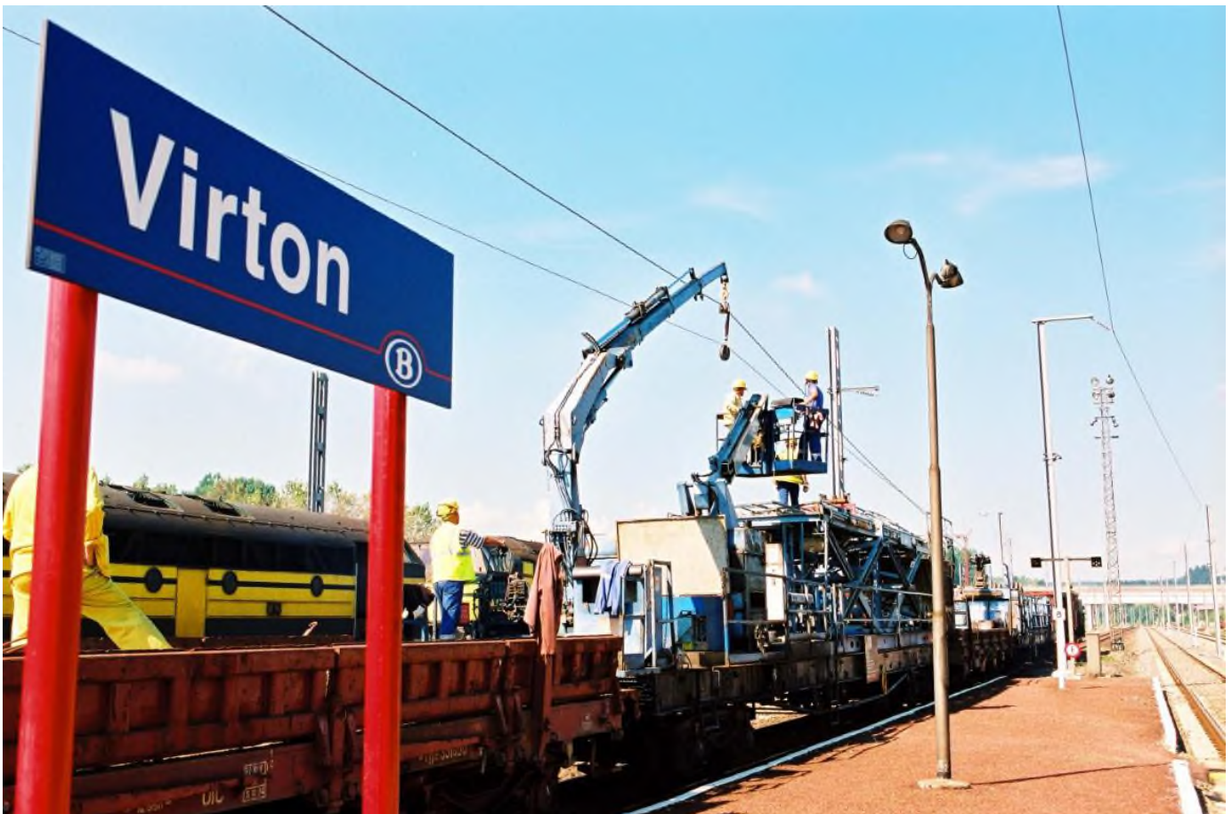
Travaux d' électrification sur l'Athus-Meuse. 08/2000 Denis Moinil (Réf. D1440-12a)
