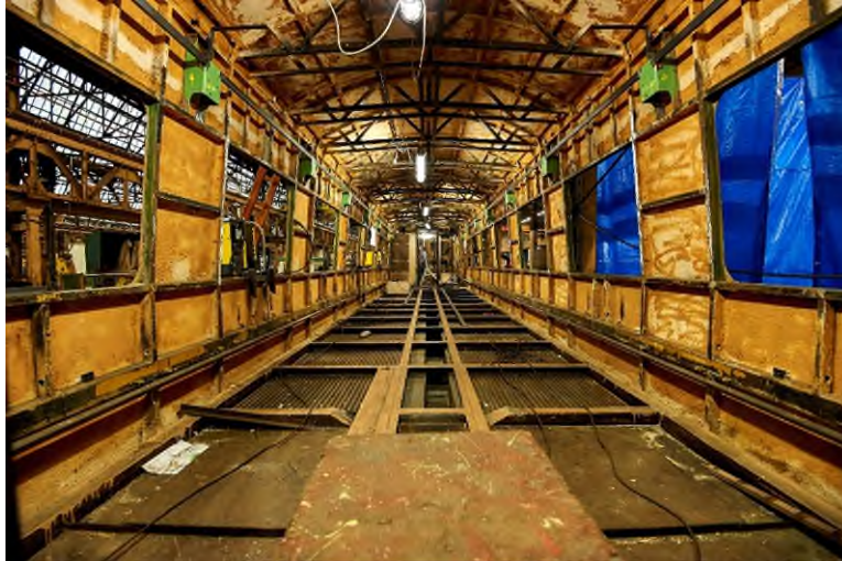
Modernisation à l'atelier central de Gentbrugge, Eric Herchaft, décembre 2014 (réf. B0074-38)
