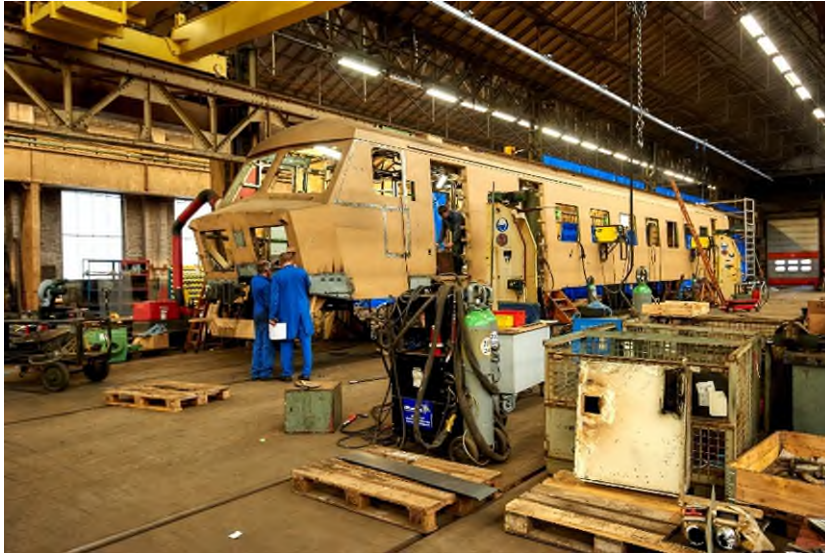
Modernisation à l'atelier central de Gentbrugge, Eric Herchaft, décembre 2014 (réf. B0074-33)
