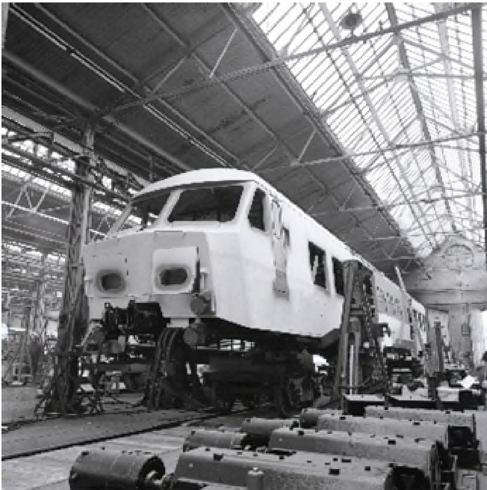
Construction des automotrices électriques quadruples à l'atelier de La Brugeoise et Nivelles, septembre 1974 (réf. Z13076B)
