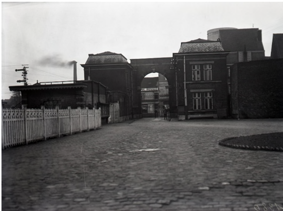
Toegangspoort tot de centrale werkplaats van Gentbrugge aan de Brusselsesteenweg 1939 (Ref. Z07093b).
