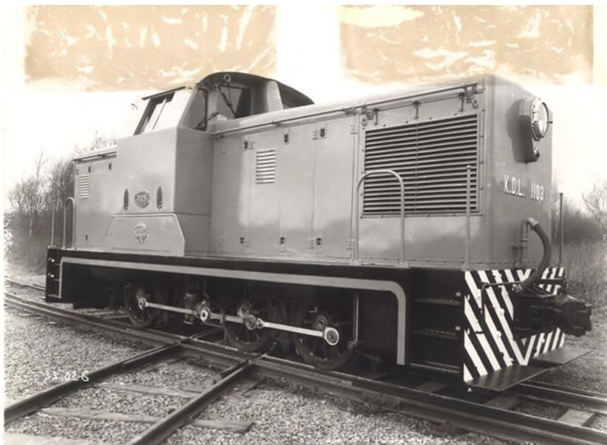
Diesellocomotief 1103 van de Chemins de fer Katanga - Dilolo - Leopoldville met een constructeursplaat van de Anglo-Franco-Belge (Ref. Z12639)
