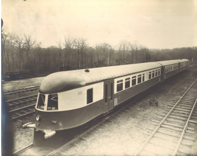
NMBS-motorwagen type 656, gebouwd in 1936 door Baume & Merpent (Ref. Z12674)
