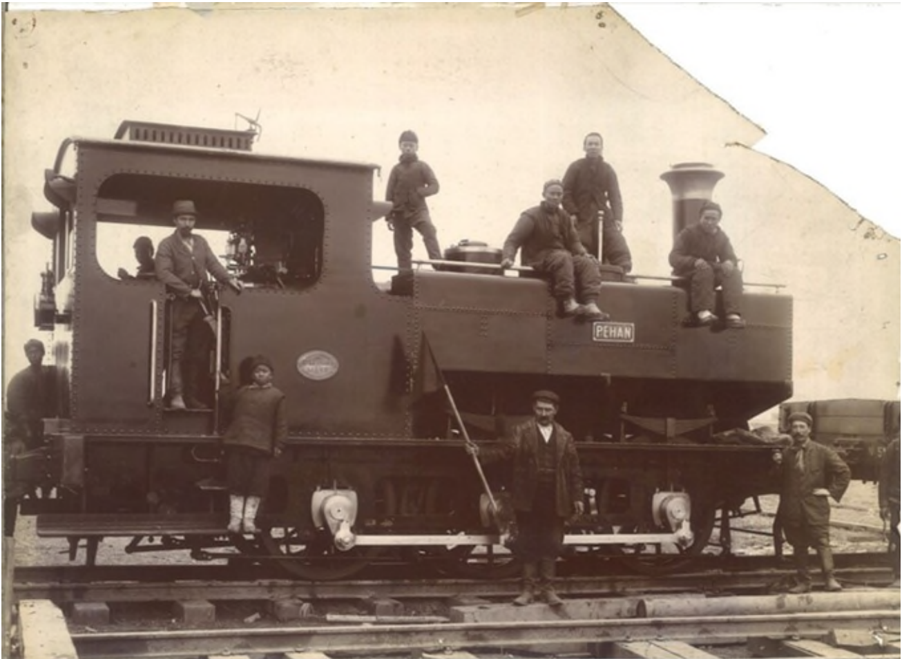
Tenderlocomotief "PEHAN", van hetzelfde type als type 51, ontworpen door Alfred Belpaire, gebouwd door de ateliers de Saint Léonard en geëxporteerd naar China (Ref. Z12638)
