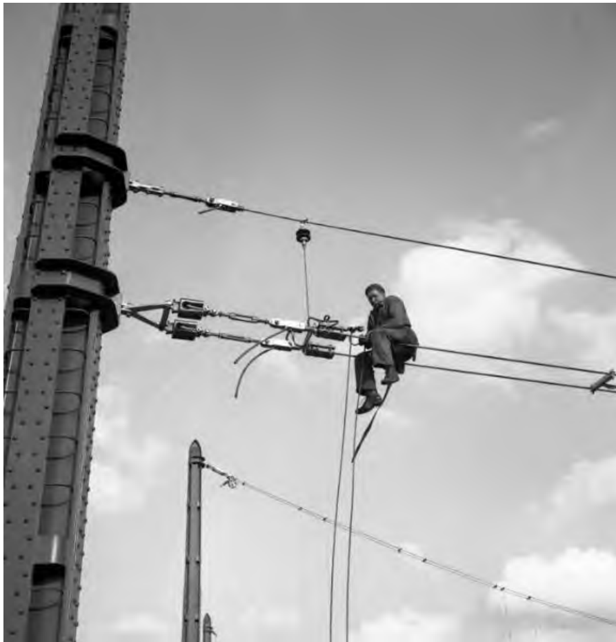
Elektrificatie van de Noord-Zuidverbinding (Ref. Z07329)
