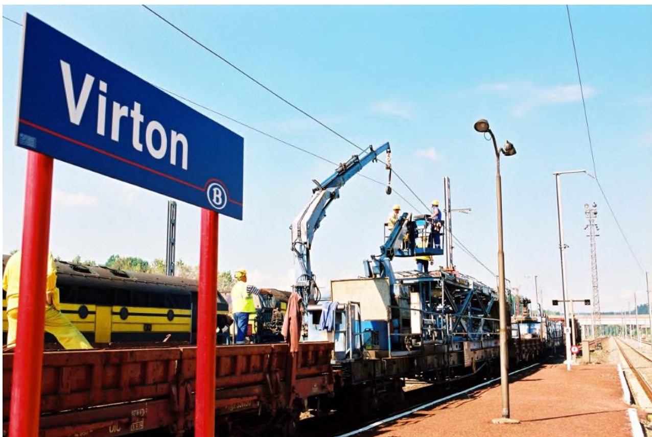
Elektrificatiewerken op spoorlijn 165 in Virton, augustus 2000, Denis Moinil (Ref. D1440-12a)
