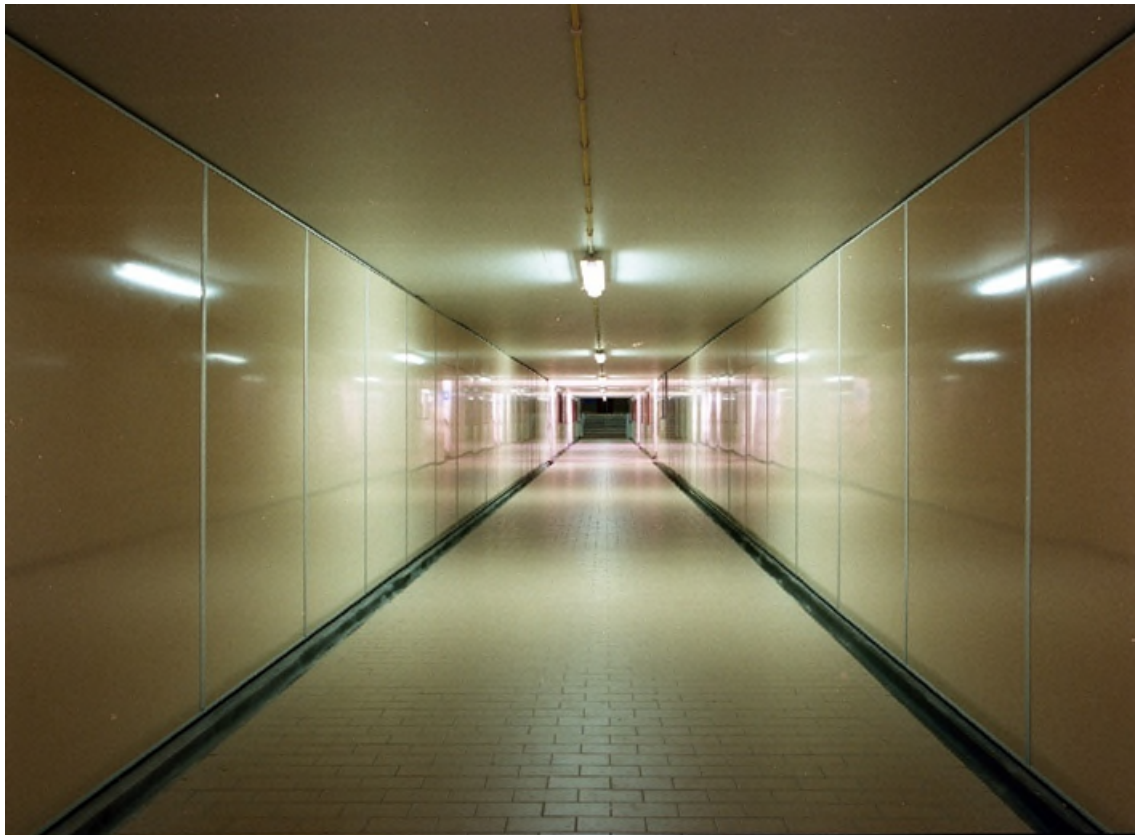
Prolongement du couloir sous voies après les travaux de rénovation, Leo Goossenaarts, 3 décembre 1999 (réf. L0642-06)
