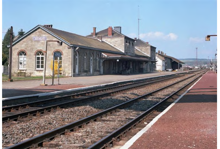
Gare d'Athus le long des voies, Denis Moinil, vers 2000-2002 (D0156-06)
