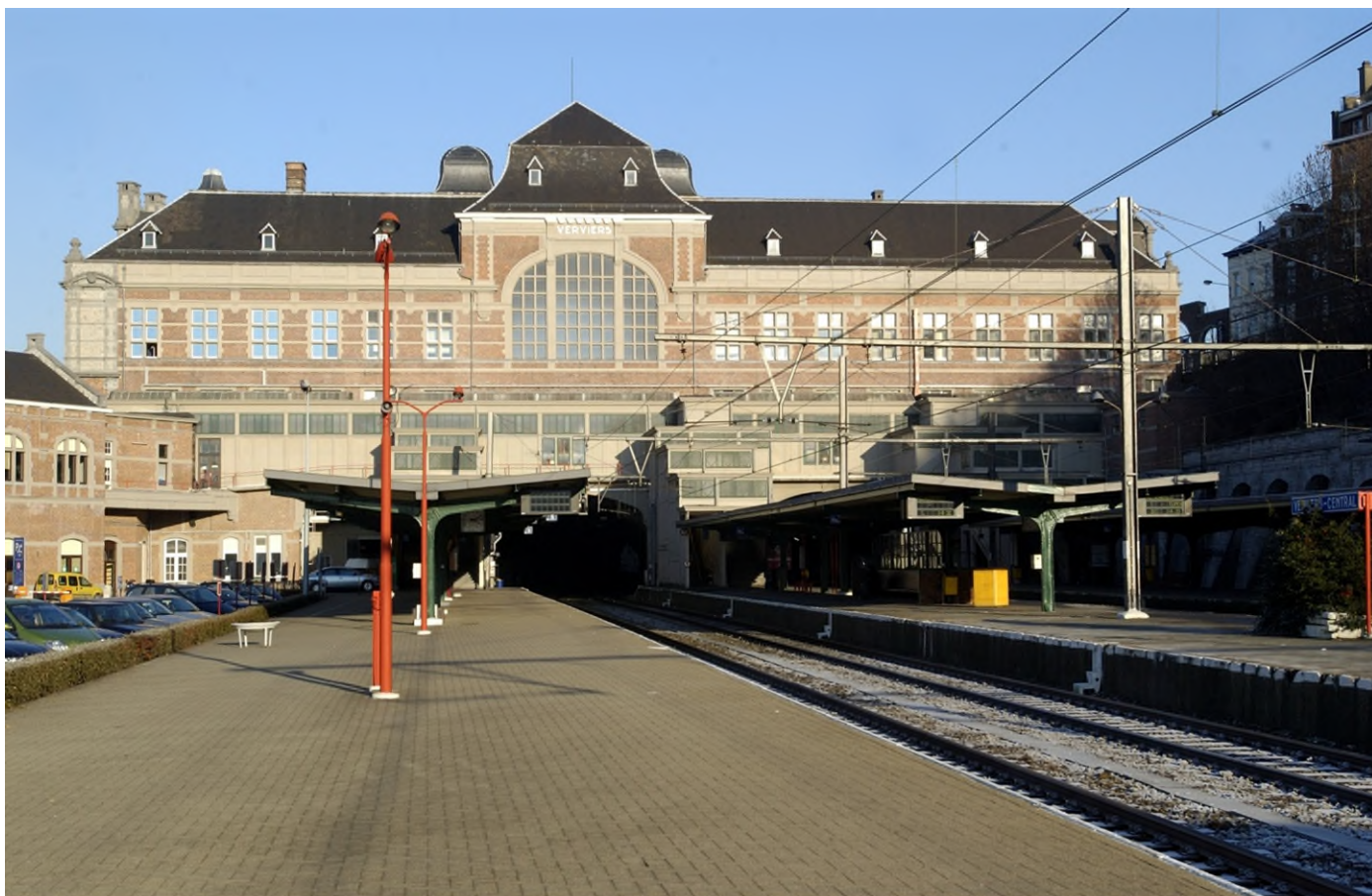
La façade arrière de la gare, Denis Moinil, juillet 2004 (réf. D2555-01)
