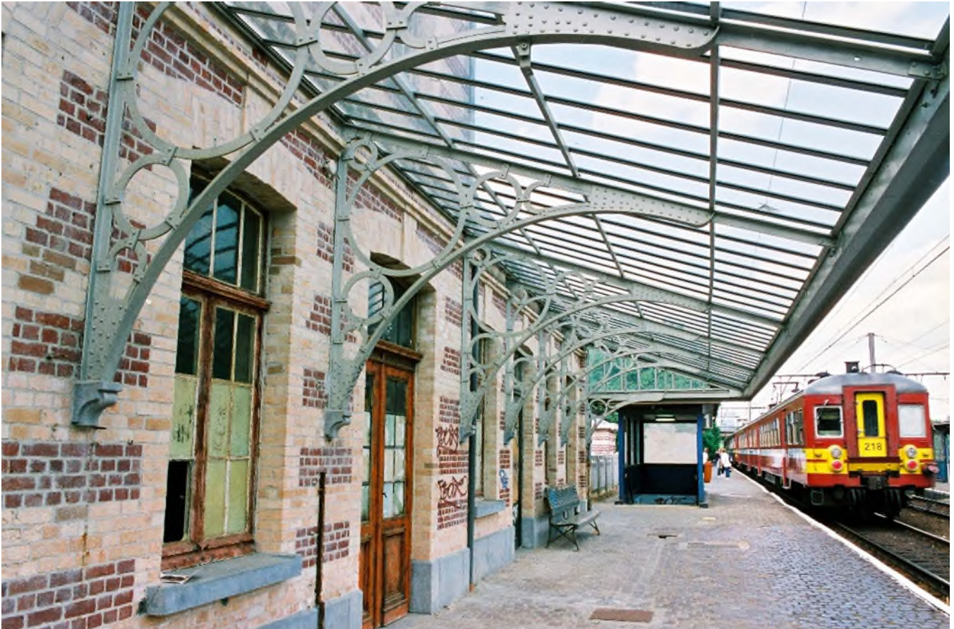
La marquise de quai, côté voies. Denis Moinil, 2002 (Réf. D2005_11a)
