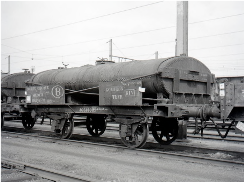
Platte ketelwagen 506560 voor het vervoer van teerproducten (Ref. Z03160)
