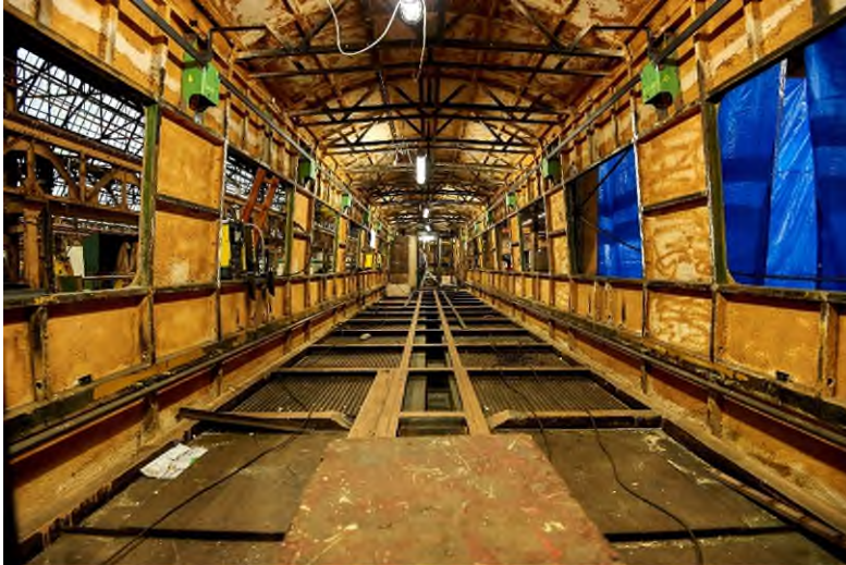
Modernisering in de Centrale Werkplaats Gentbrugge, Eric Herchaft, december 2014 (Ref. B0074-38)
