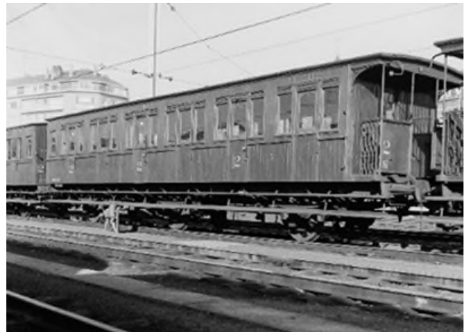
Rijtuig 95872 na verbouwing tot een rijtuig met middengang (Ref. Z05946)
