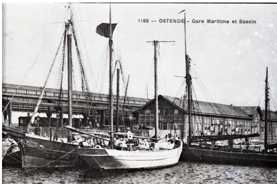
Carte postale de la première gare provisoire avec à l'arrière la marquise surplombant les voies (réf. Z00970)
