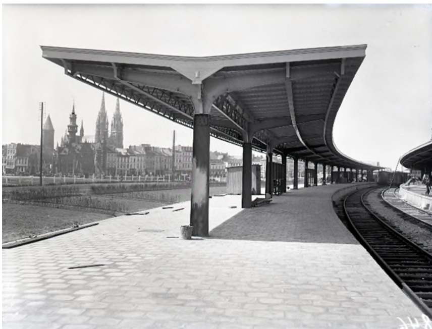
Auvents des quais en construction, 1930 (réf. Z07073a)
