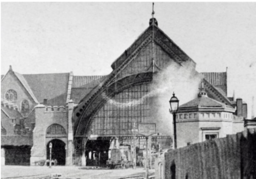
Le hall de voies de la deuxième gare de Bruges, détail d'une carte postale (Ref. Z00233)
