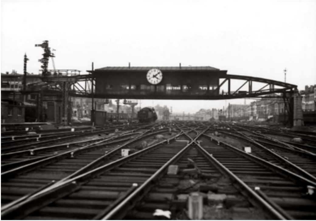
Cabine de signalisation au-dessus des voies à Bruxelles-Nord (Réf. Z03865)
