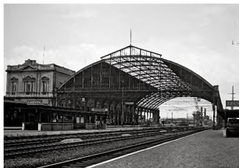
L'ancienne marquise pendant la démolition, 1953 (Réf. Z03445A)
