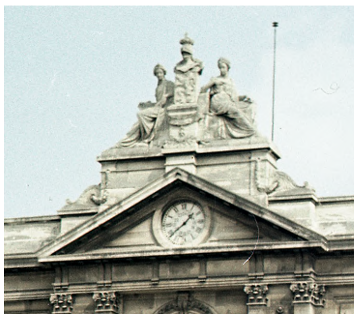
Détail du fronton sur la façade (Réf. K00040a)
