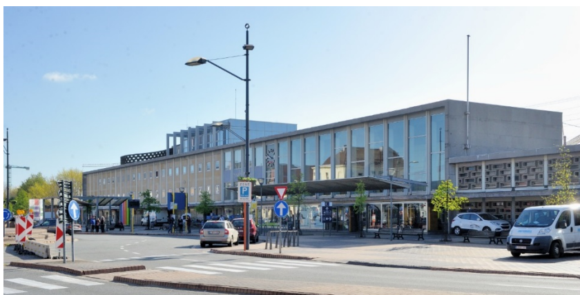
Troisième gare de Malines, côté rue (Réf. D4152-2)
