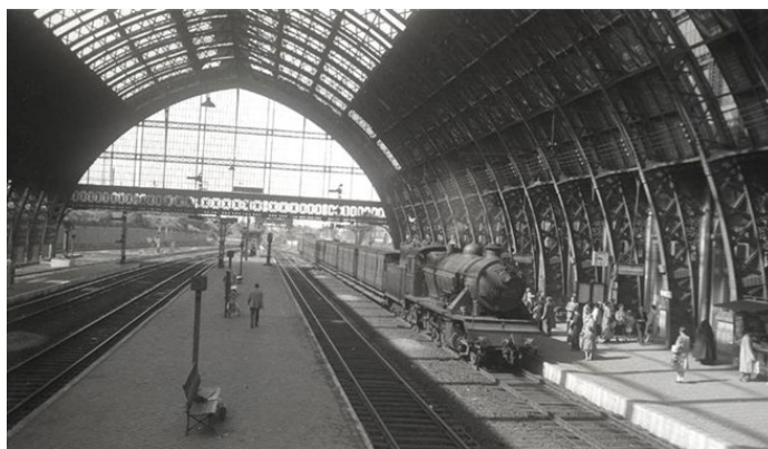
La marquise de la deuxième gare de Malines (Réf. Q0142)
