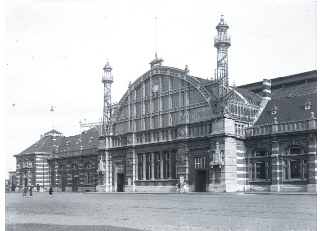
Deuxième gare de Malines côté rue (Réf. Z03428A)
