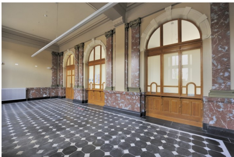
La salle des guichets de la gare de 1887, restaurée, 2015 (Réf. D4085-02)
