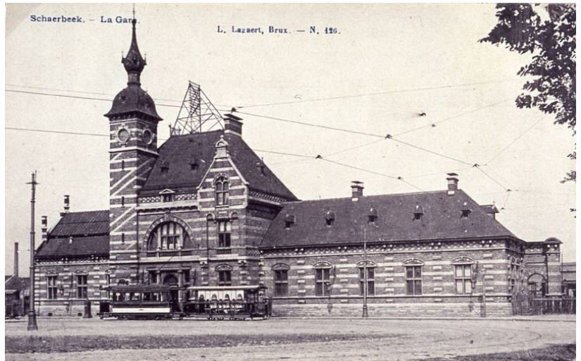
Façade principale de la gare de 1887 Réf. Z01584)
