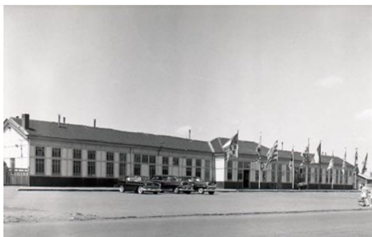
Gare d'Ypres : construction temporaire en remplacement de la première, détruite durant la Première Guerre Mondiale. Photo prise en 1961 (Réf. Z08790)
