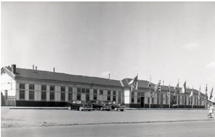
Station Ieper: tijdelijke constructie ter vervanging van het eerste station dat verwoest werd tijdens de Eerste Wereldoorlog. Foto genomen in 1961 (Ref. Z08790)
