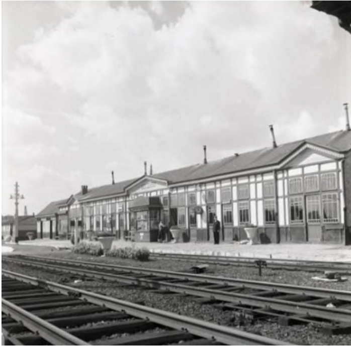
Tijdelijk station Torhout in 1960 (Ref. Z02838)
