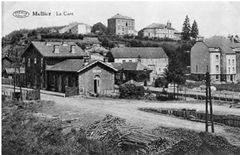
Postkaart van het station Mellier, dit was het eerste stationsgebouw van Aarlen (Ref. Z01277)
