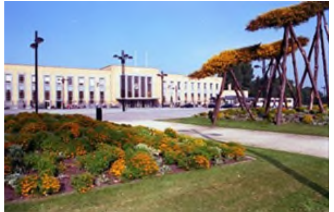
Het huidige station Brugge, 1999 (Ref. L0520-04)
