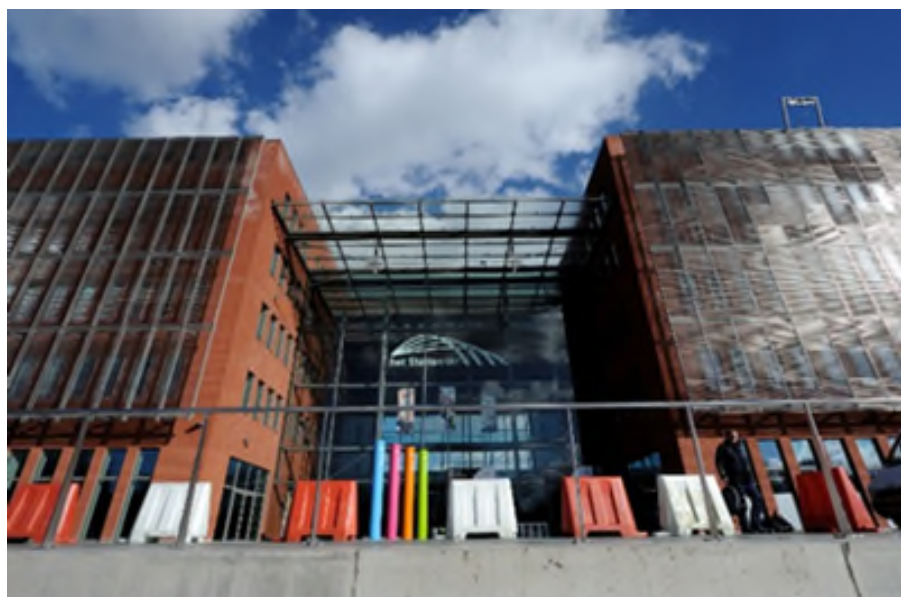
De ingang aan de achterzijde na de verbouwingen, 14 februari 2011 (Ref. D3664-10)
