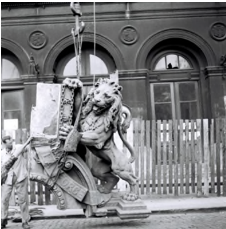
De beelden worden naar beneden gehaald tijdens de afbraakwerken van het oude station in 1955 (Ref. Z07261J)
