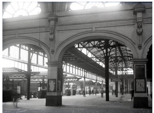
Binnenzicht van het tweede Zuidstation (Ref. Z04606)
