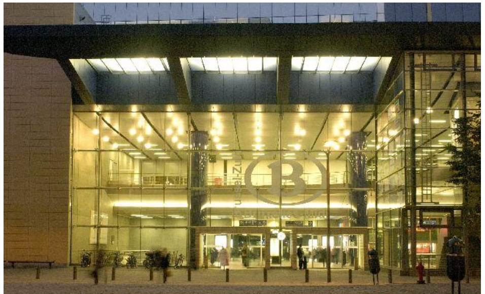
De ingang van het vierde station Brussel-Zuid aan het Hortaplein (Ref. D2853-19)
