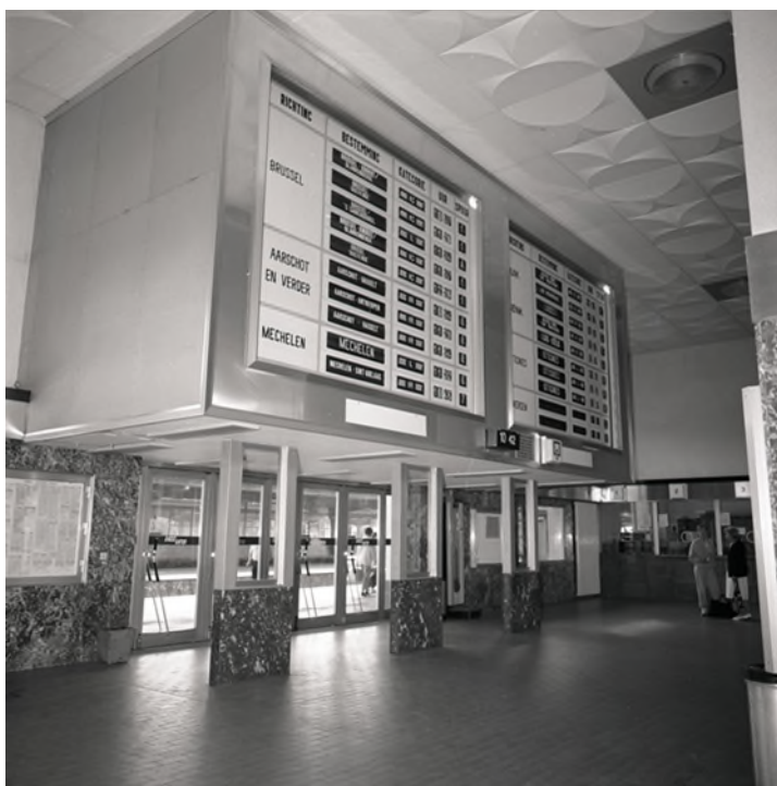
Mechanische treinaankondiger in het station Leuven, 1987 (Ref. Z11391E)
