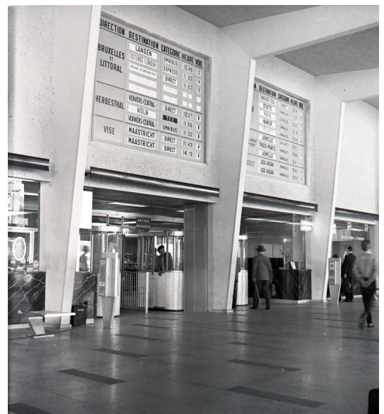
Automatische treinaankondiger in de lokettenzaal van het derde station Luik-Guillemins (Ref. Z03483B)
