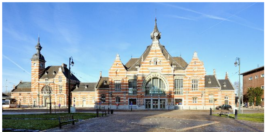
Hoofdgevel van het station, 2011 (Ref. D3548-01)
