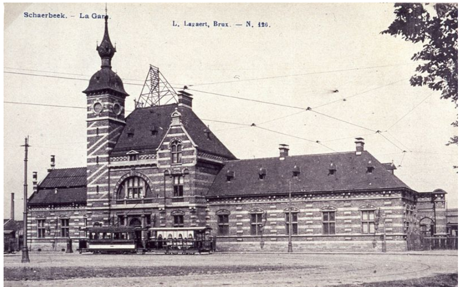
Hoofdgevel van het station uit 1887 (Ref. Z01584)
