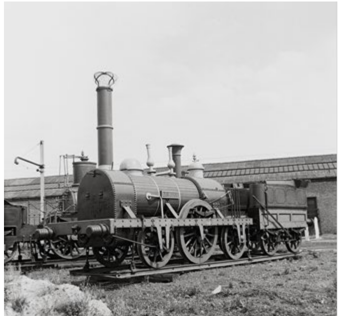
Replica in hout van stoomlocomotief Le Belge in de centrale werkplaats Mechelen (Ref. Z00067)
