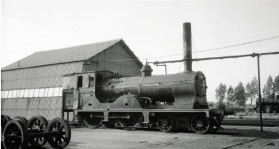
Stoomlocomotief A511/323 zonder tender in Hasselt, gebruikt als vaste stoomgenerator in de werkplaats van Hasselt. (Ref. Q0175)
