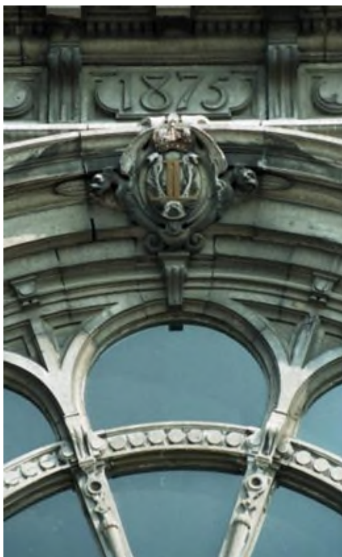
Detail van de gevel (Ref. D0973-05A)
