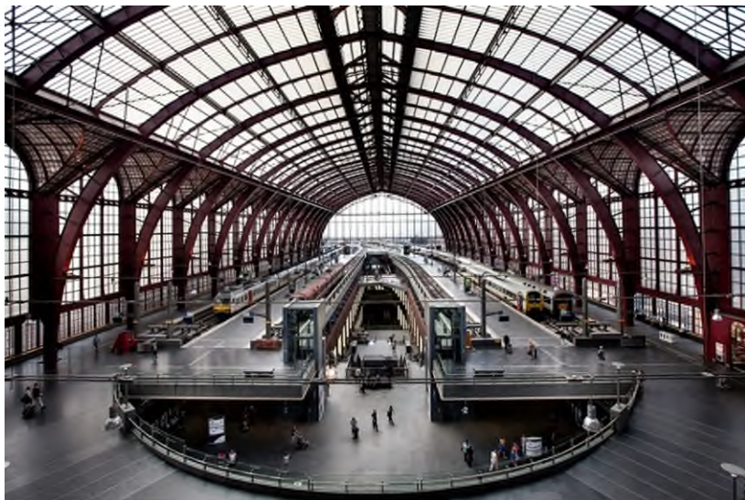
De overkapping na de renovatie, 2010 (Ref. B0056-06)
