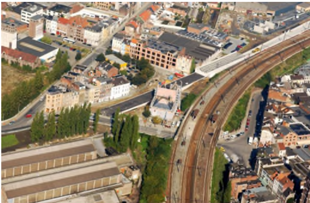
Luchtfoto's aanleg spoorlijn 25 tussen Antwerpen-Dam en Antwerpen-Luchtbal (Ref. L2603-01)
