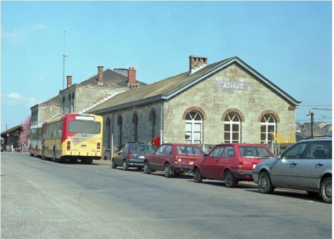
Station Athus langs de straatzijde, Denis Moinil, ca. 2000-'02 (D0156-08)
